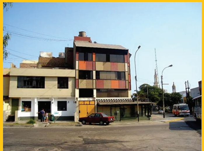
Edificio en Miraflores que tuvo paneles fotovoltaicos, obteniendo energía del sol.
